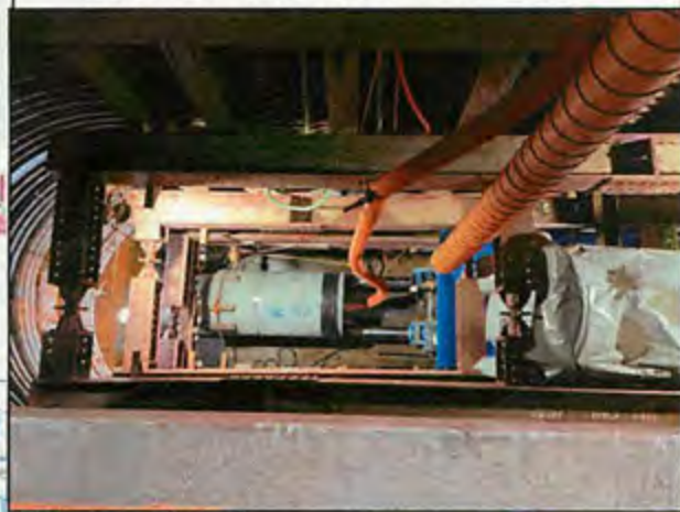
推進工法 推進施工中イメージ (立坑内)
